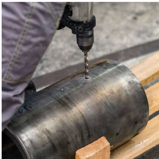
Slika 7. Demontaža starog ležaja/ Dismantling the old bearing
