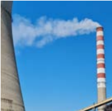
Dimnjaci i dimovodi/ Chimneys and flues
